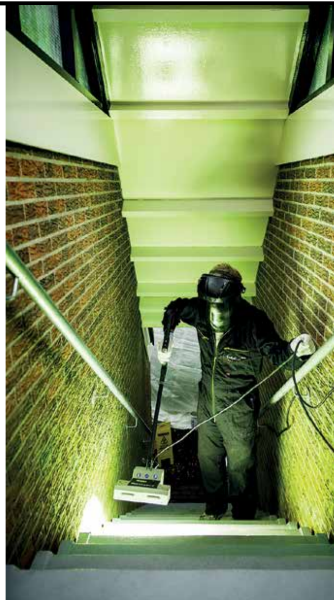
Bij het complete SolidLux systeem gaat het niet alleen om de speciale vloercoatingsproducten, maar juist om de combinatie met de UV-apparatuur die nodig is voor de directe uitharding.
