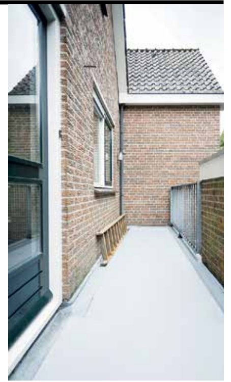
De galerijen in het woningcomplex in Bergen kregen dezelfde supersnelle behandeling met SolidLux.
