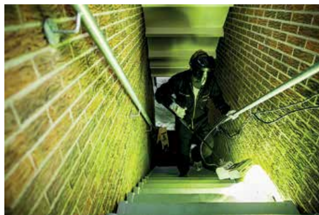
De directe uitharding van de coating gebeurt onder invloed van UV-licht dat – voor de toepassing bij trappen – via een handlamp boven de coating wordt gehouden. Voor galerijen is er een 'lampenwagen'.
