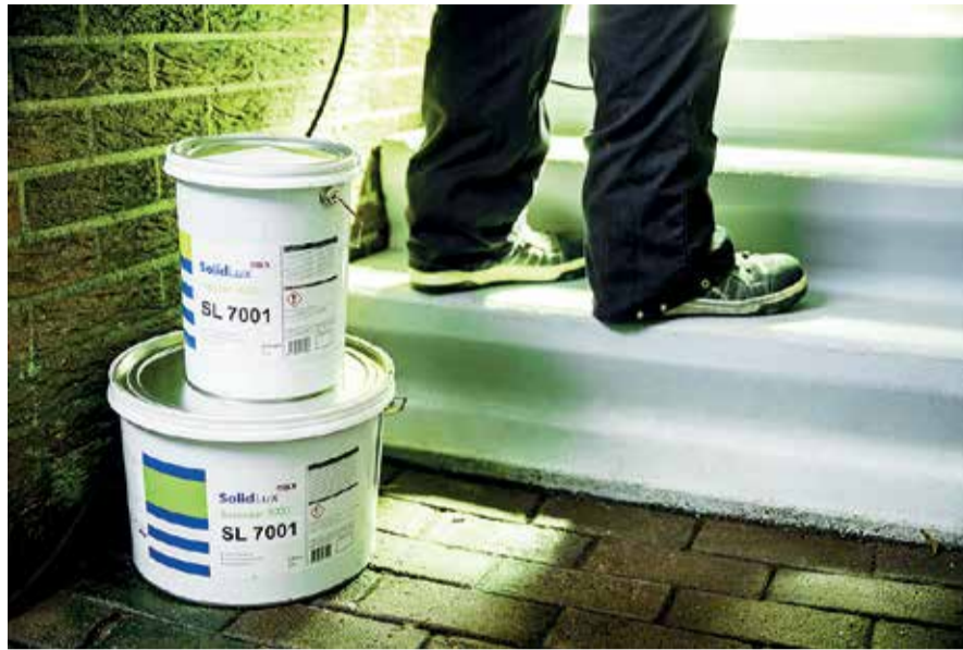
Als de ondergrond niet te zeer beschadigd is, kan worden volstaan met een basecoat (primer) en één laag topcoat.
