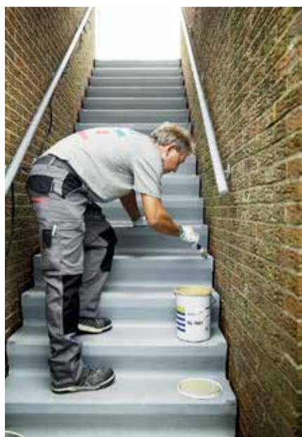
Met een roller en kwast worden de traptrreden één voor één in de coating gezet.
