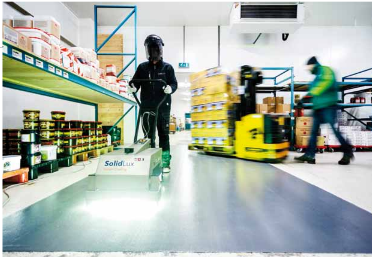
▲ Door de instant uitharding is het mogelijk om een SolidLux vloercoating praktisch 'tussen de bedrijven door' aan te brengen.
